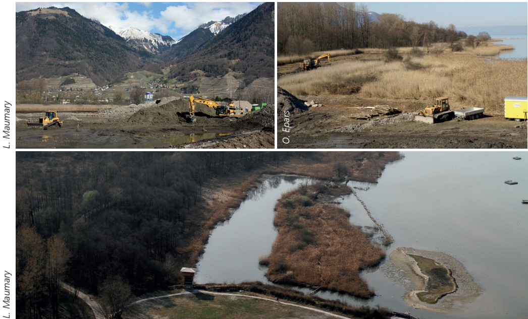
Travaux de création de la nouvelle lagune des Saviez en mars 2008 et état en 2012 pour l'image du bas.
